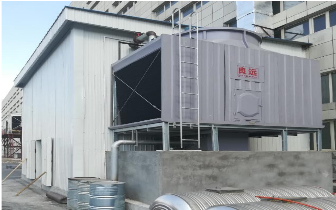
NMP 废气回收系统
