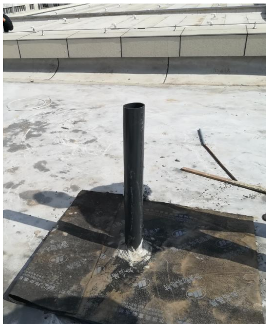
污水站排气筒
